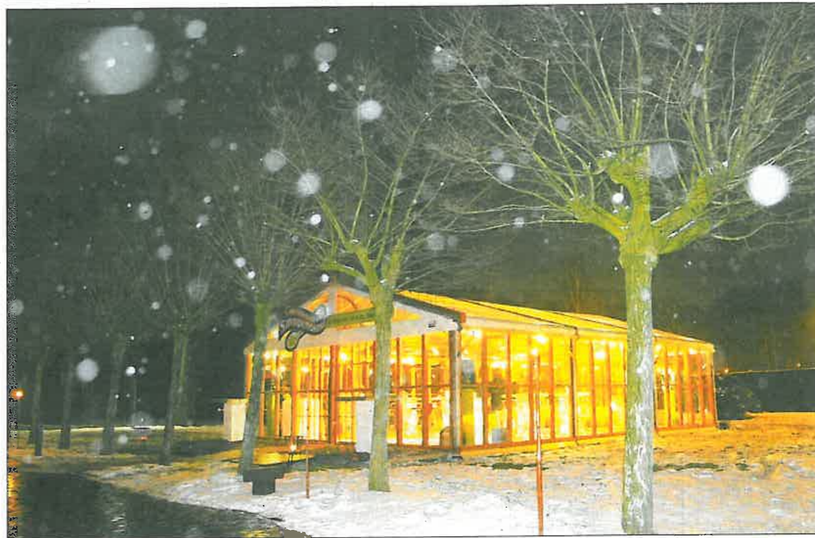
De stichting 's-Hertogenbosch Hoofdstad van de Smaak 2010 heeft een tuinbouwkas laten bouwen. Het is de bedoeling dat deze kas zo'n vijftien keer bij steeds weer een ander 'smaakmakend' evenement komt te staan. Een voorbeeld is het Theaterfestival Boulevard.
